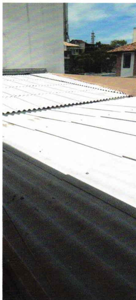
Troca das telhas
